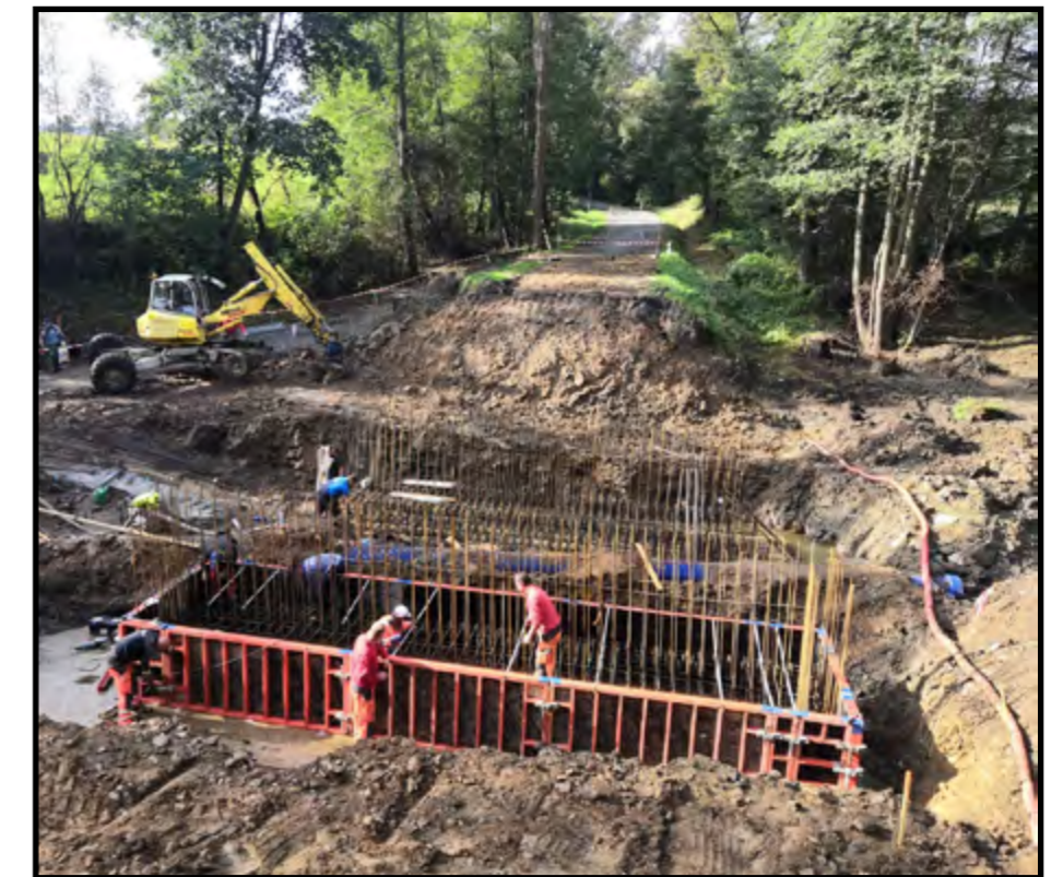
OPRAVA MOSTU. Oprava mostu na silnici směrem na přehradu probíhá podle plánu.
